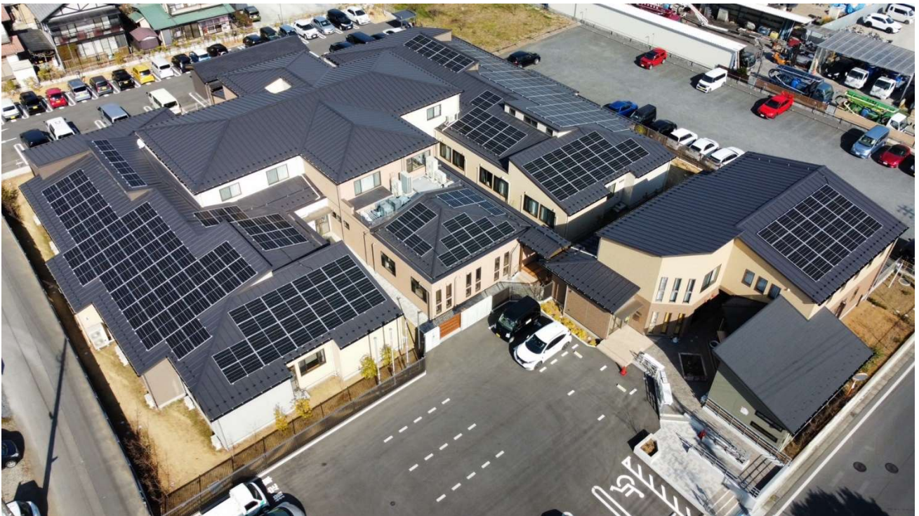
(図2) 太陽光発電設備を備えた日の出太陽の家の全景
