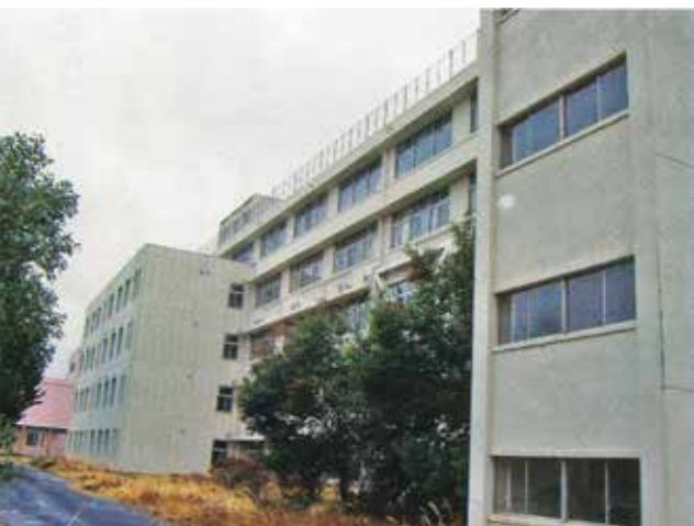
村山病院入院病棟
